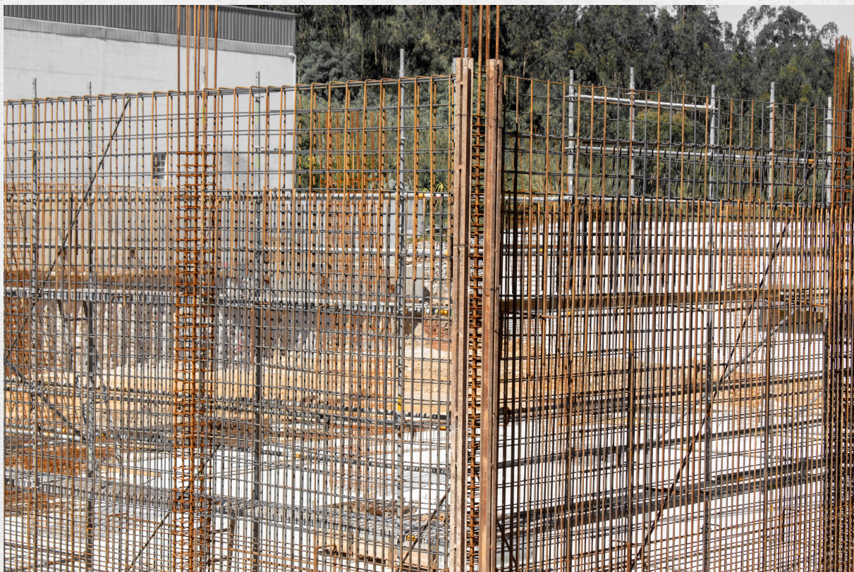
Рисунок 11. Скрытые работы принимает технический надзор: после бетонирования проверить арматуру уже нельзя. Снимок иллюстративный
